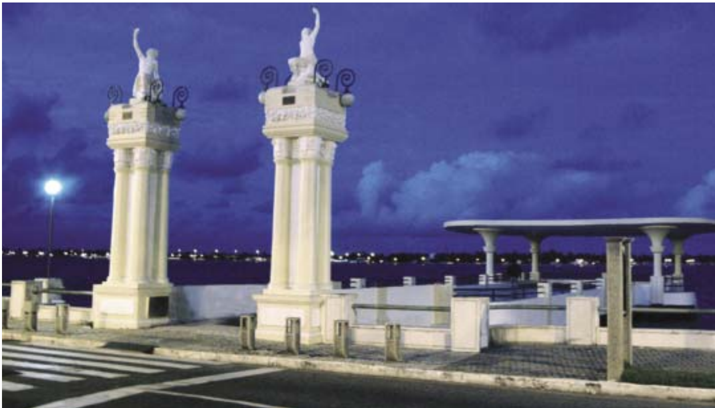
Ponte do Imperador em Aracaju, capital de Sergipe, onde os investimentos recuperaram-se em 2004, depois da queda de 2003
