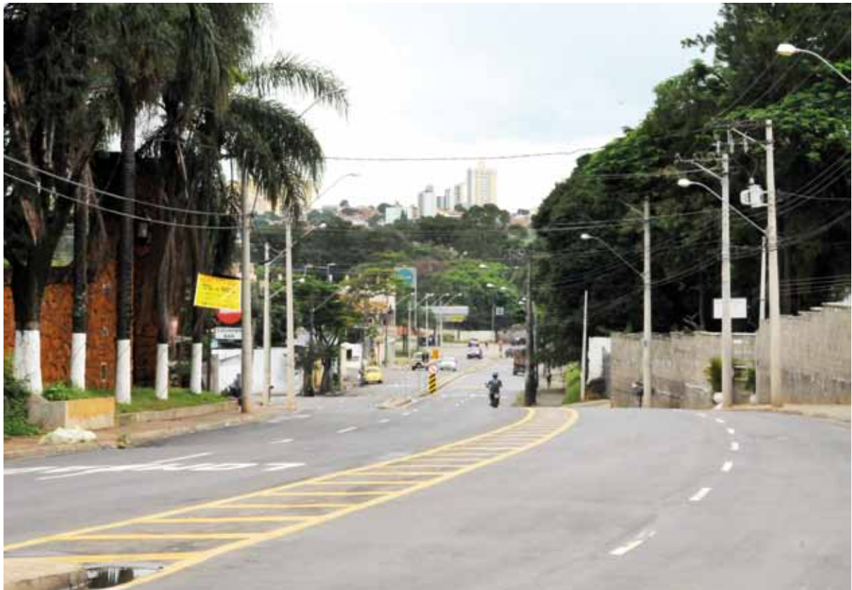
Pavimentação da Avenida Rio das Pedras
