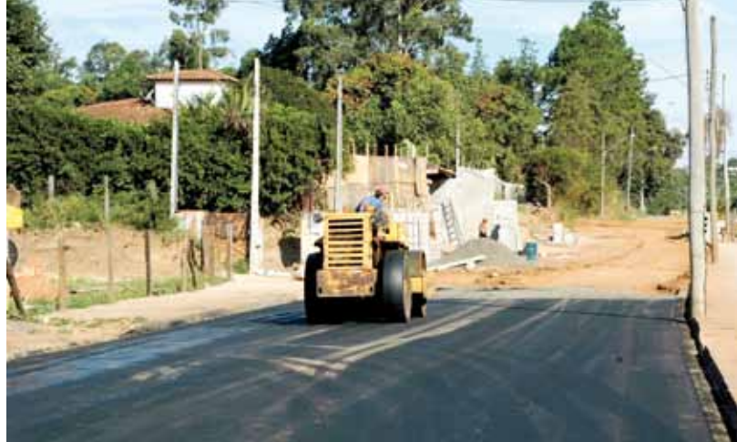
Pavimentação da Avenida Pompeia
